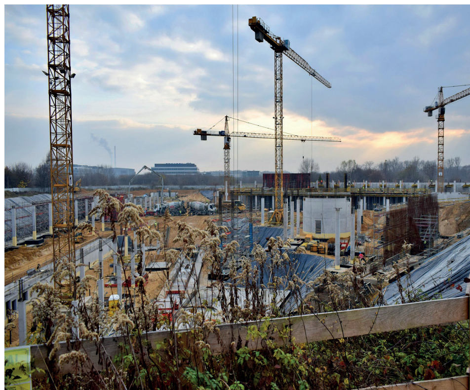
Cogiteon, Budowa siedziby w Czyżynach, fot. Archiwum Cogiteon
